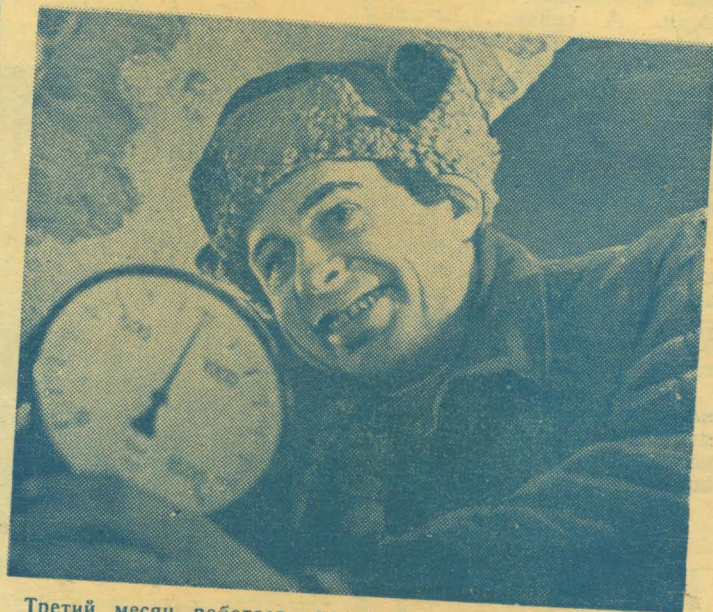
Третий месяц работает на стройке бригада трубопроводчиков Ильи Семенова. Сейчас она ведет монтаж кристаллизаторов. До пуска корпуса № 985 остались считанные дни,
