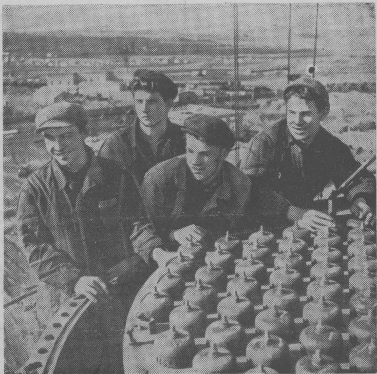
БРИГАДА МОНТАЖНИКОВ КМУ-1 ТРЕСТА «СИБМЕТАЛЛУРГОМОНТАЖ», ВОЗГЛАВЛЯЕМАЯ ИВАНОМ ФЕДОСЕЕВЫМ, ОБЯЗАЛАСЬ КО ДНЮ ОТКРЫТИЯ XXII СЪЕЗДА КПСС ДОСРОЧНО ЗАКОНЧИТЬ ВСЕ НАРУЖНЫЕ МОНТАЖНЫЕ РАБОТЫ.
