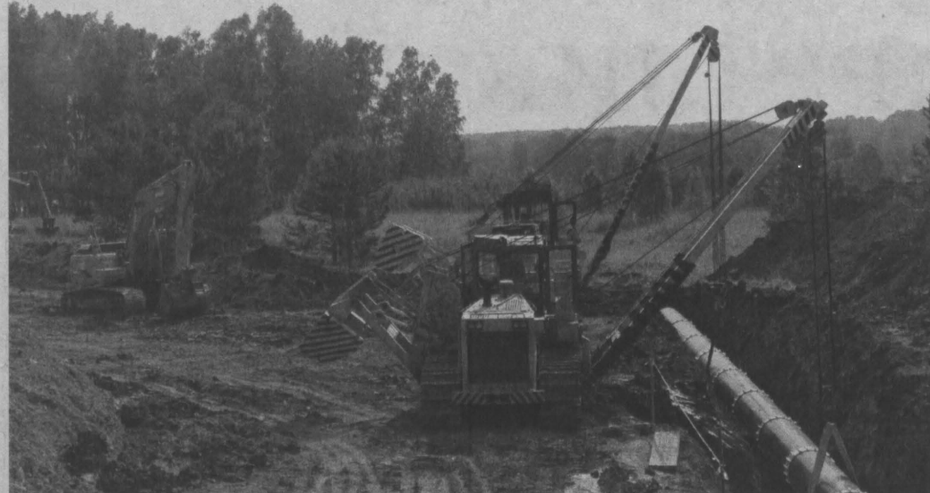
Ремонтные работы на переходе через автодорогу.
