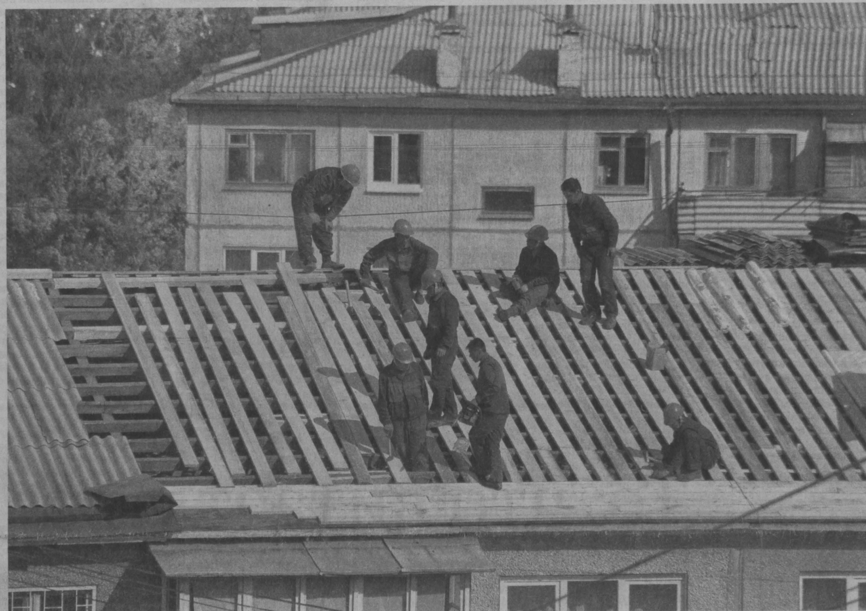
Ремонт крыши — один из обязательных видов «капитальных работ». Фото Федора Баранова.
