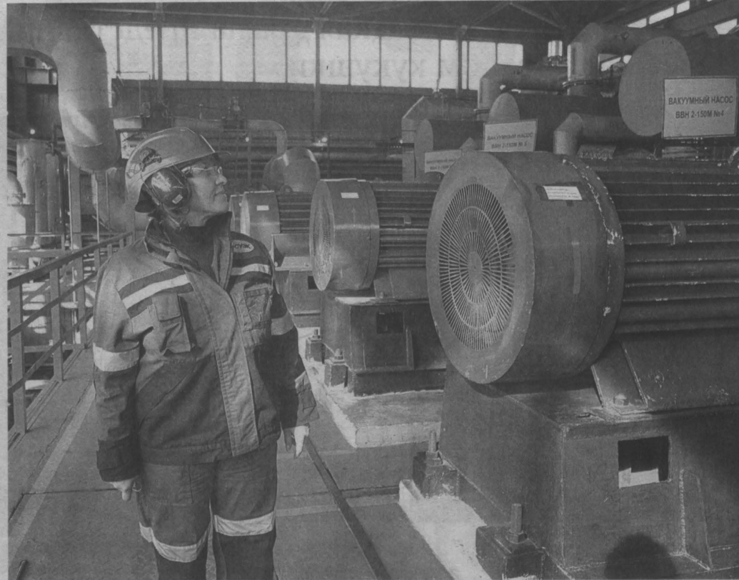
Вакуумные насосы, подающие метан для полезной утилизации, на шахте имени С.М. Кирова.
