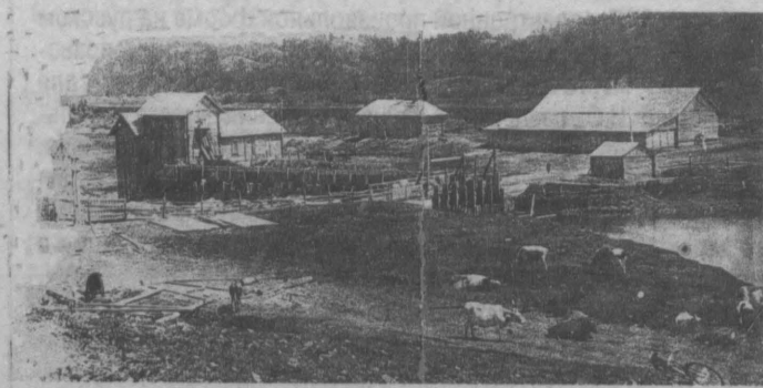
■ Строительство первой в Сибири сельской гидроэлектростанции на реке Ур в Гурьевском районе, 1926 год.
