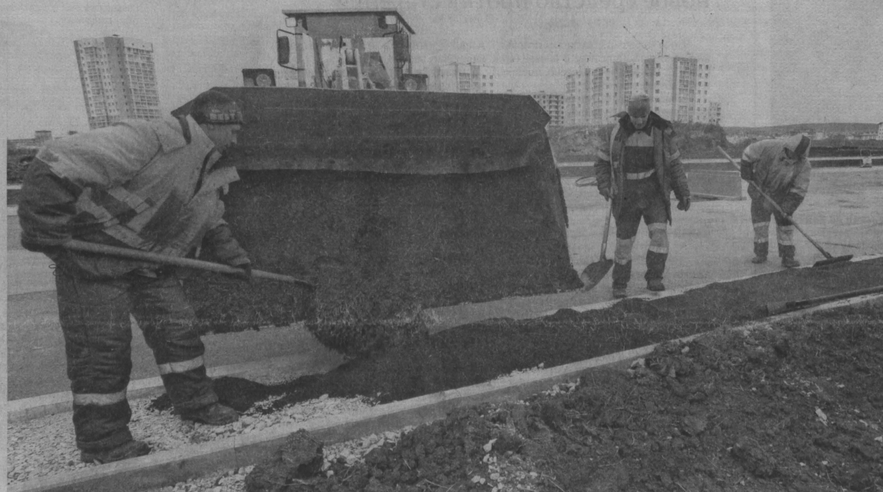
Асфальт на дорогу строители положили еще по теплу, сейчас заканчивают сопутствующие работы. Фото Федора Баранова.
