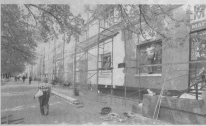
■ Ремонт фасадов в центре Кемерова уже начался. Фото Федора Баранова.
