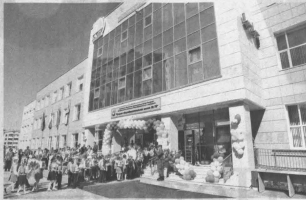
В кемеровской школе на Южном построен спортблок с 25-метровым бассейном. Фото Федора Баранова.
