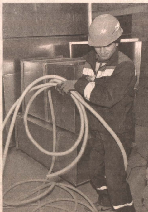
■ В центре завершается отделка, монтируется сложнейшее оборудование.
