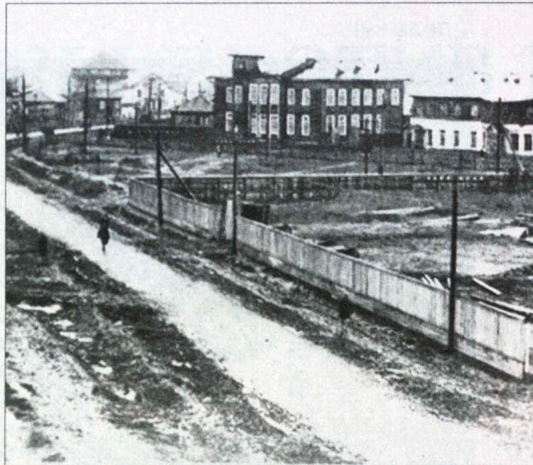
■ Площадка под строительство ДК «Москва».
