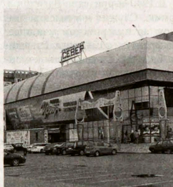
■ Неделя понадобилась собственникам, чтобы устранить нарушения в «Севере».
