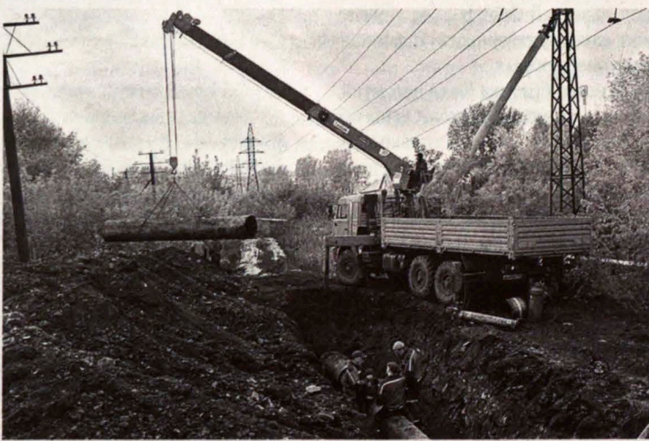
■ Перекладка водопровода в районе шахты «Тырганская».
