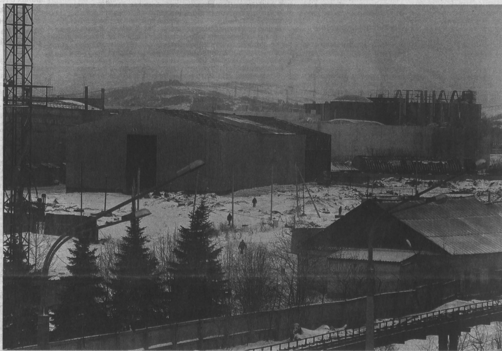
Строительство ритейл-парка на бывшей территории КМК. Фото Ярослава Беляева.
