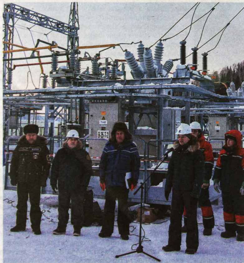
■ Торжественное открытие подстанции.
