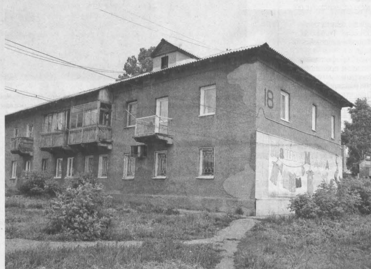
Дом №18 по улице Луначарского все не «безнадежен». Фото автора.
