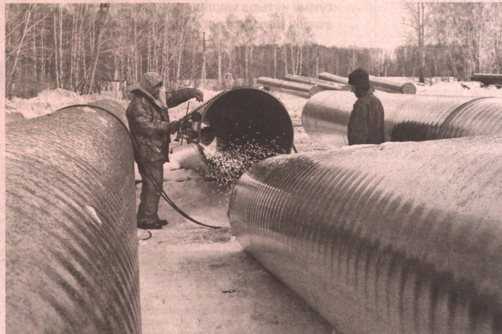
На сварочной базе идет подготовка новой трубы и укладке.
