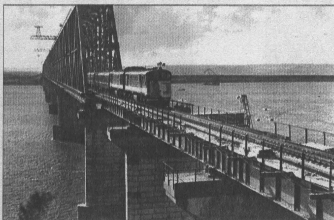
Самый длинный мост на БАМе – железнодорожно-автомобильный мост через Амур (1400 м).
