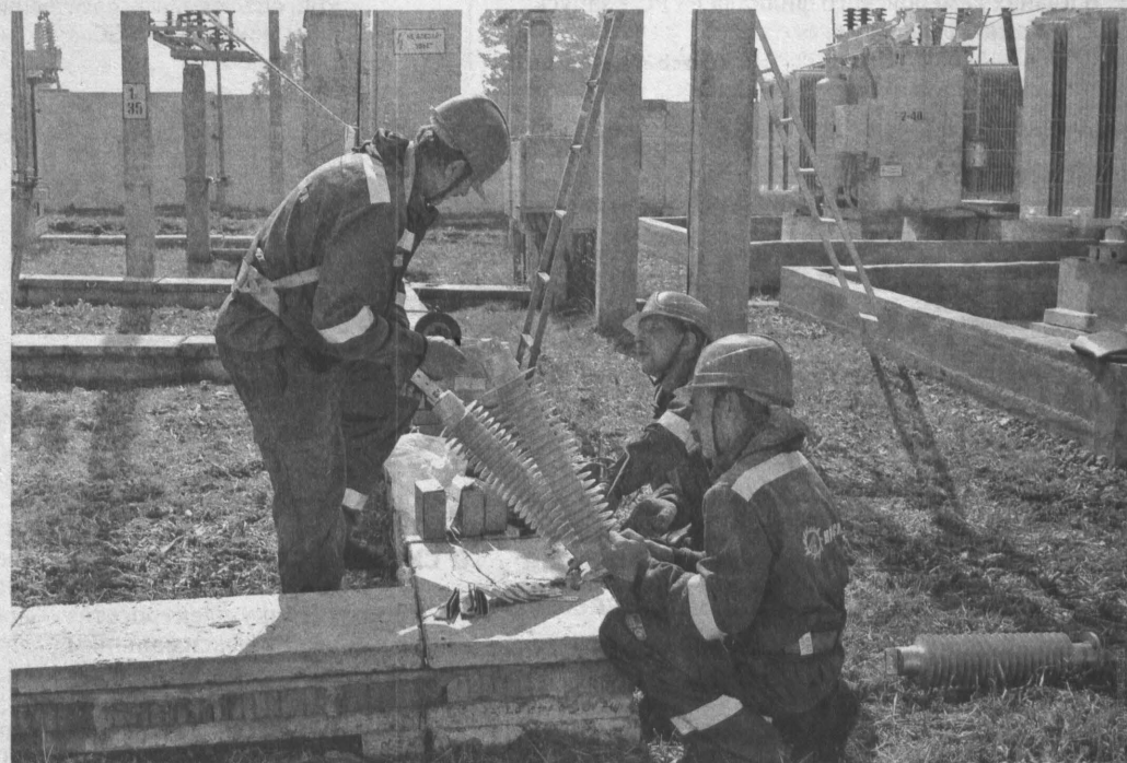
Персонал «Кузбассэнерго – РЭС» проводит ремонтные работы на подстанции.
