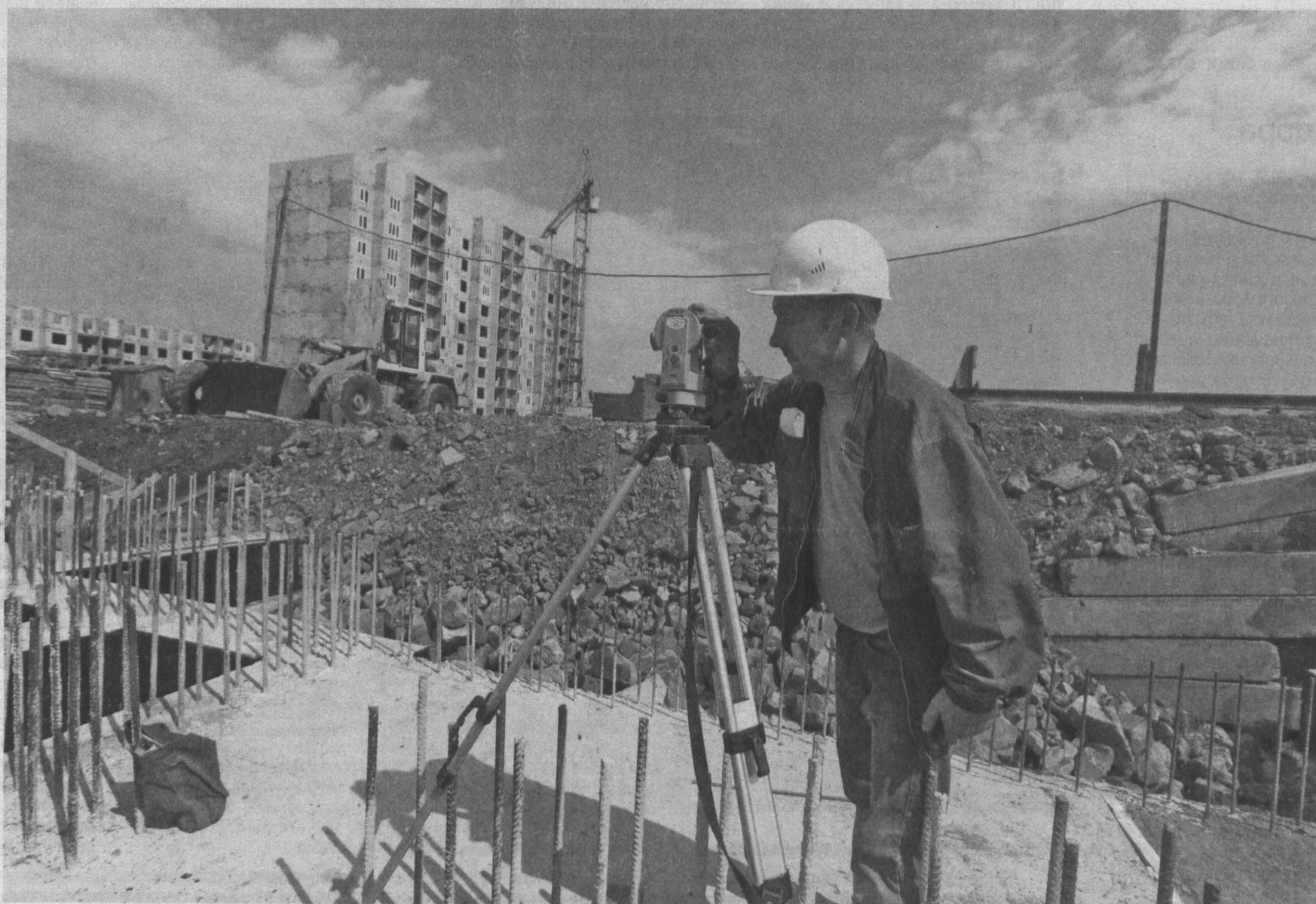
В Ленинском районе Кемерово возводится новый микрорайон №68, где можно будет купить жилье по социальной ипотеке. Фото Сергея Гавриленко.
