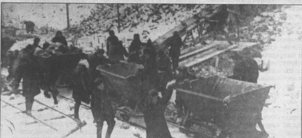
Строительство Кемеровской ГРЭС. Фото из архива предприятия.
