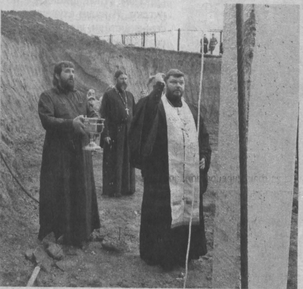
Забита первая свая в строительство храма.
