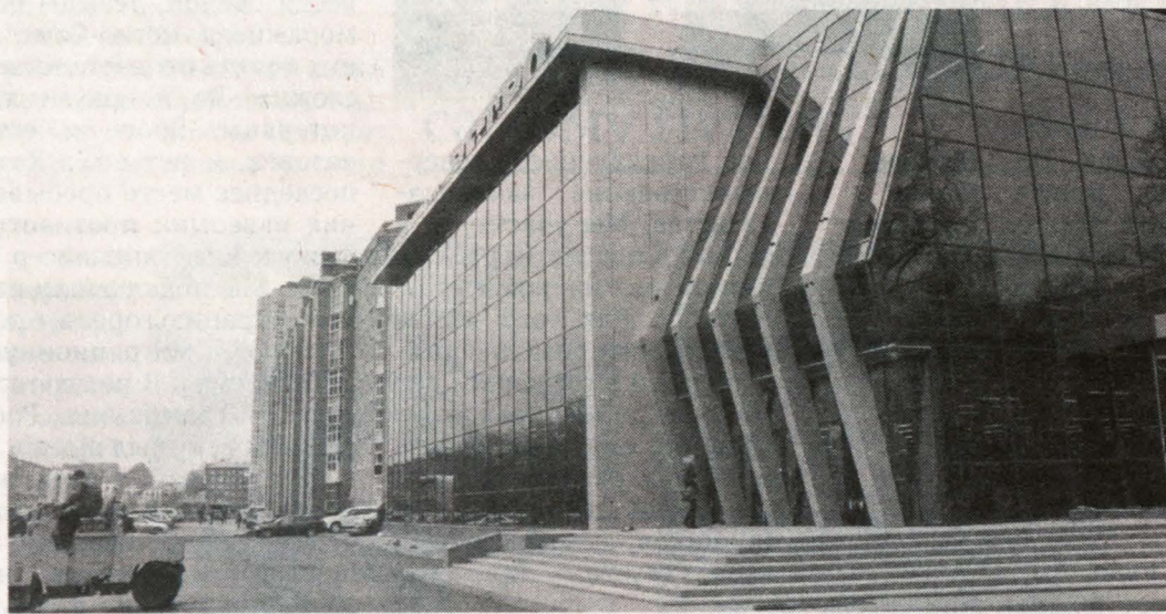
Последние приготовления к открытию.
