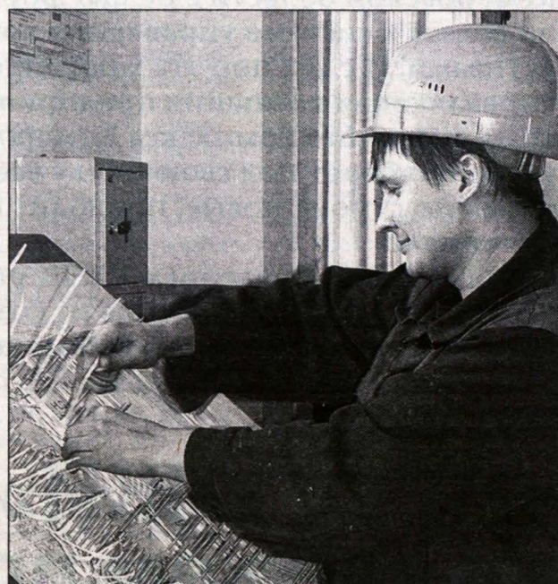
Электромонтажник Алексей Егоров на сборке ячеек КСО.
