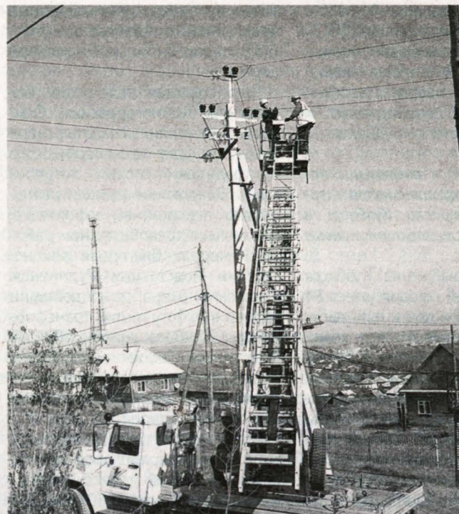
Ремонт воздушной линии электро- передачи
