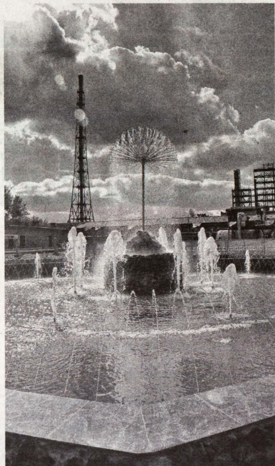
В Кемерове, на промплощадке ОАО «Азот», появился фонтан диаметром 30 метров и высотой струй 5 метров. А рядом разбит сквер с лавочками и цветниками. Между тем раньше на этом месте было законсервированное технологическое сооружение, которое демонтировали.
