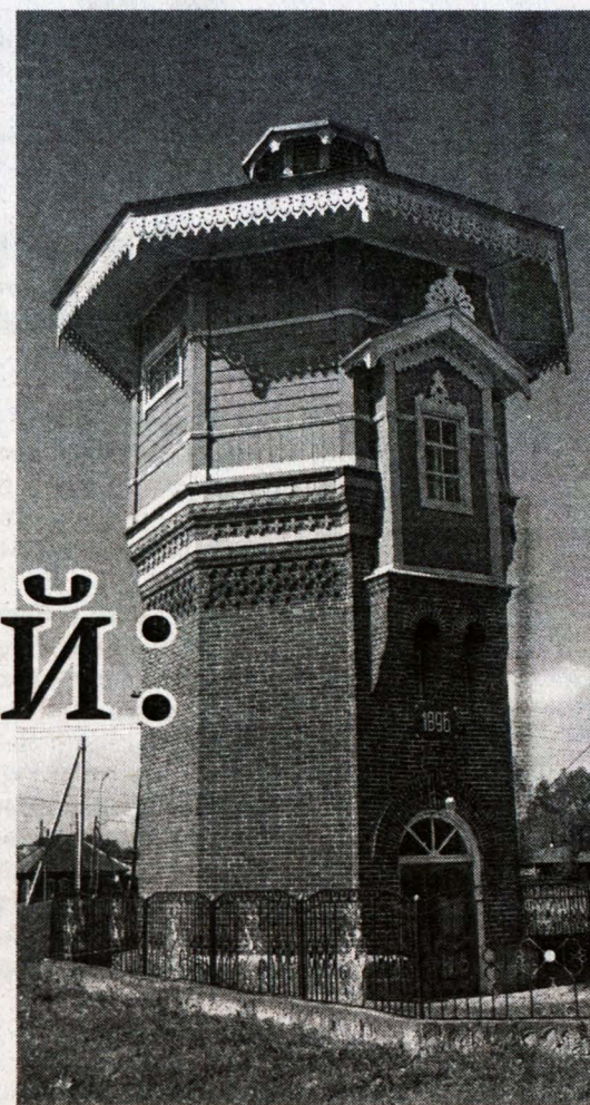
Башня — ровесница станции.
