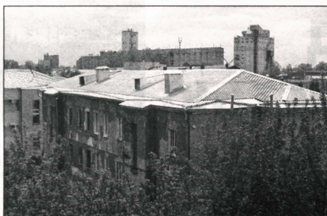
Сейчас на доме уже новая крыша...
