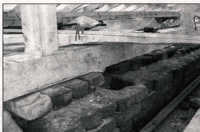
...Но положены балки на «голые» кирпичи...
