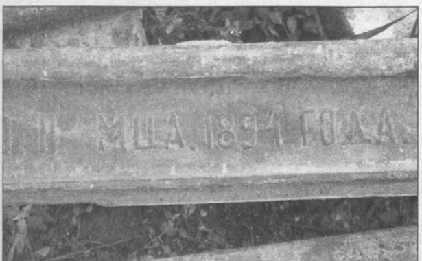
Рельс из основания колокольни.
