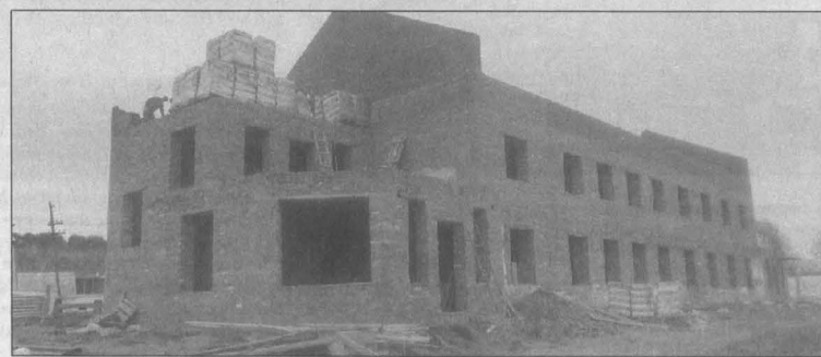
Полностью возведена коробка здания.
