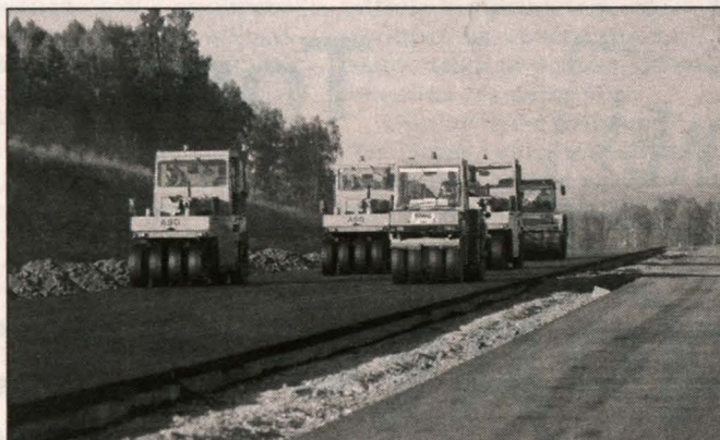
В процессе строительства нового участка дороги «Кемерово-Ленинск-Кузнецкий».
