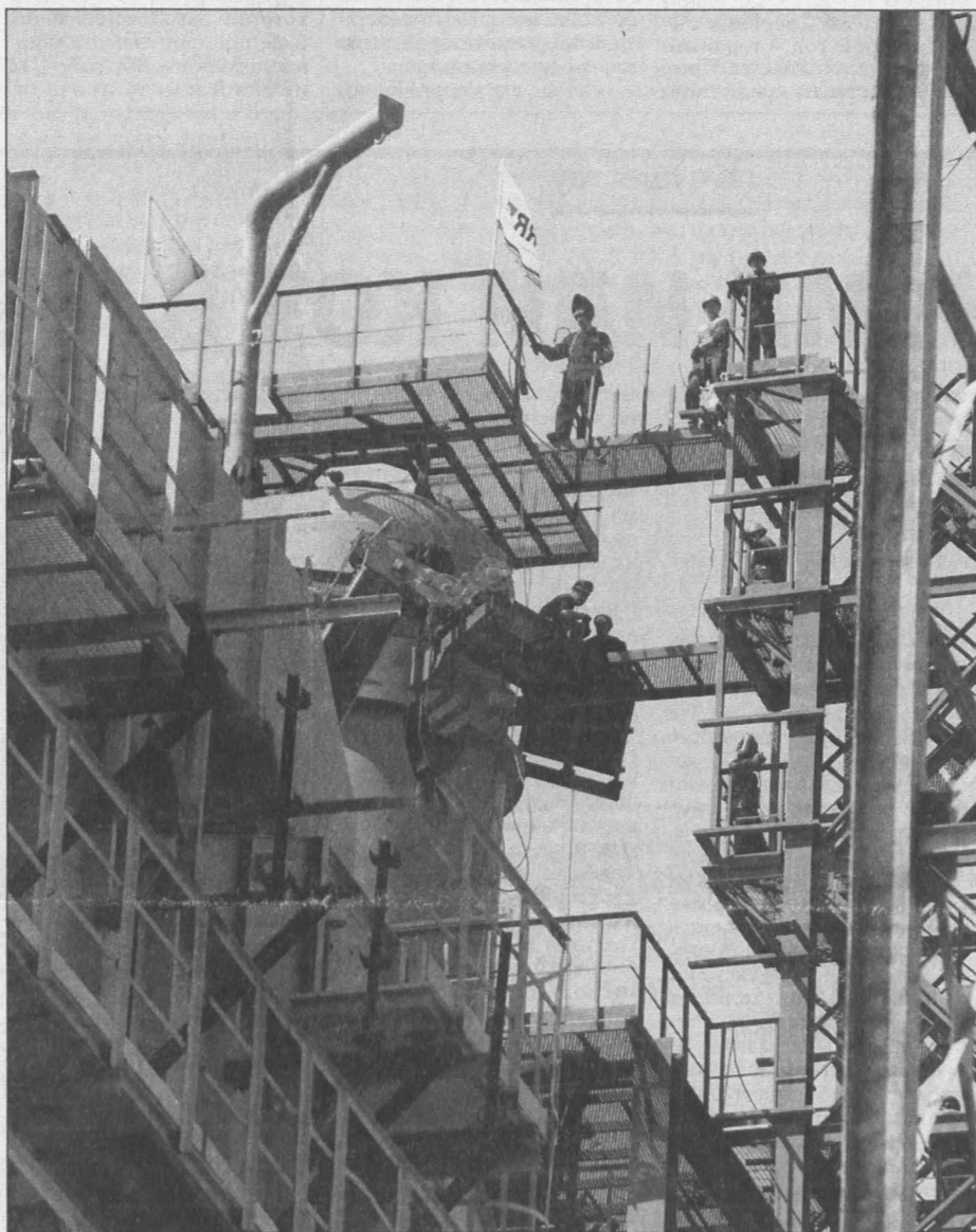
Эту 60-метровую колонну в Яю доставили специальным маршрутом из Волгограда. В городах перед ней снимали троллейбусные линии. Места зазоры под мостами были всего 5 см.
