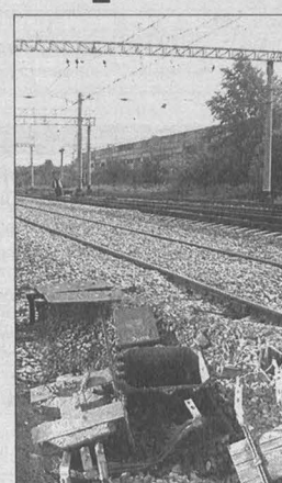
Выведенные из строя дроссель-трансформаторы создают реальную угрозу безопасности движения поездов.
