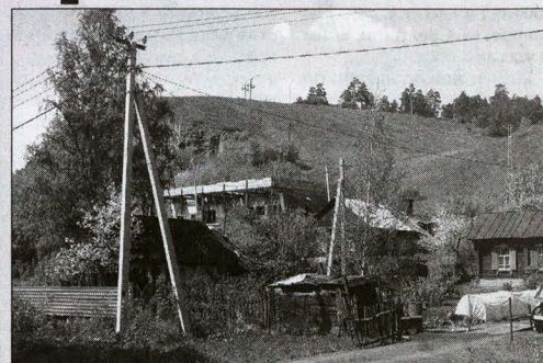
Так выглядит реконструированная ЛЭП.
