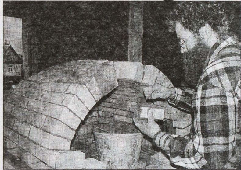
Кладка свода печи без опалубки.
