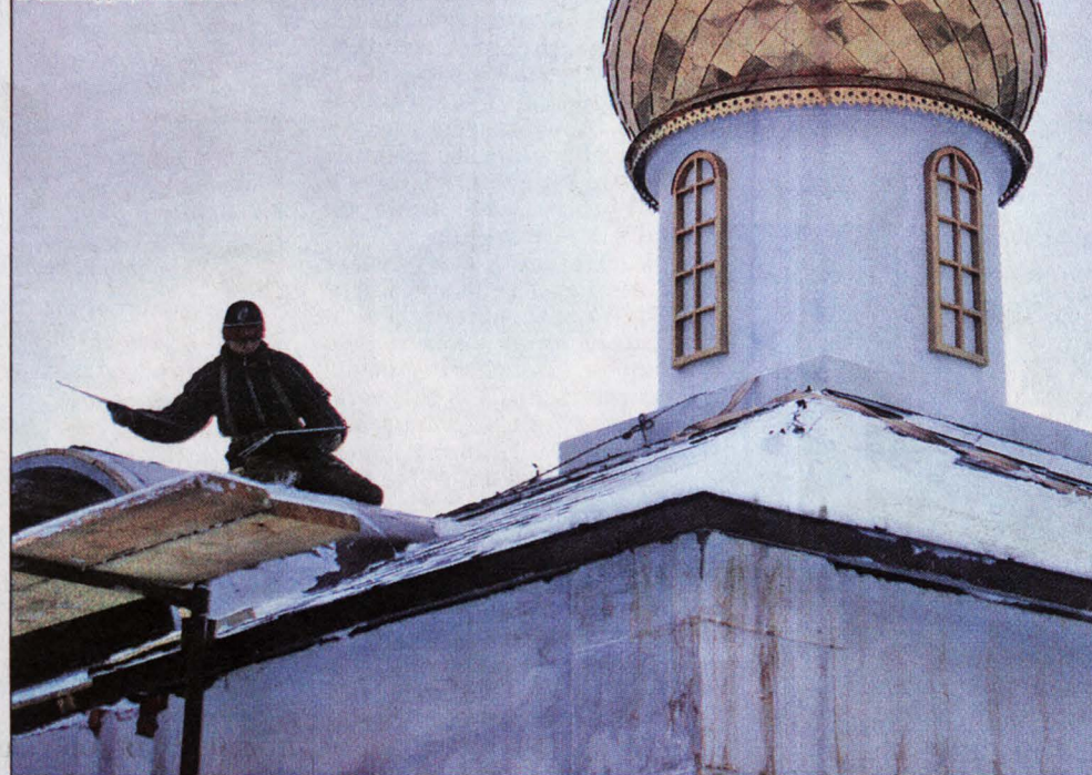
Строительство храма завершается.
