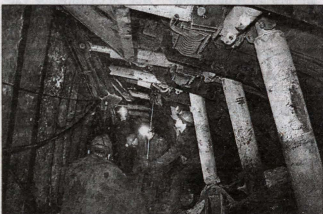
Монтаж крепи в забое шахты «Распадская», за 30 лет здесь прошли испытания десятки типов механизированных крепей, очистных узкозахватных и проходческих комбайнов, конвейеров. 1975 г.
