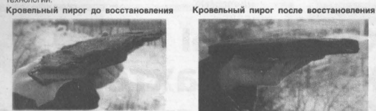
Кровельный пирог до восстановления Кровельный пирог после восстановления
