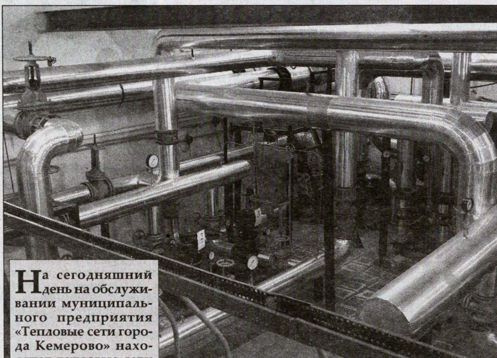
Трубы, утепленные K-FLEXом на КРП.
