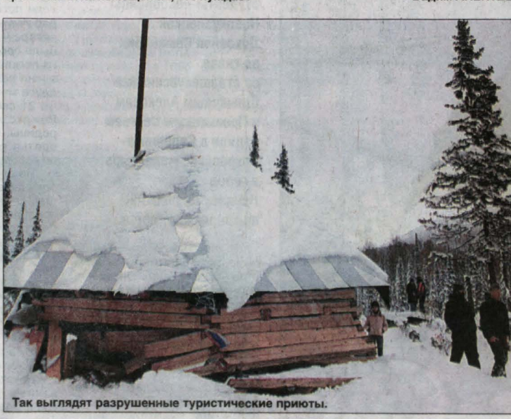
Так выглядят разрушенные туристические приюты.
