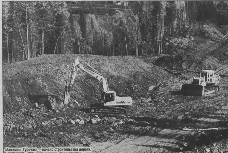
«Алтамаш-Турочак» — начало строительства дороги
