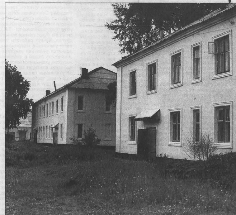
Дома на ул. Куйбышева после ремонта, выполненного ООО «Ремонто-эксплуатационная организация».
