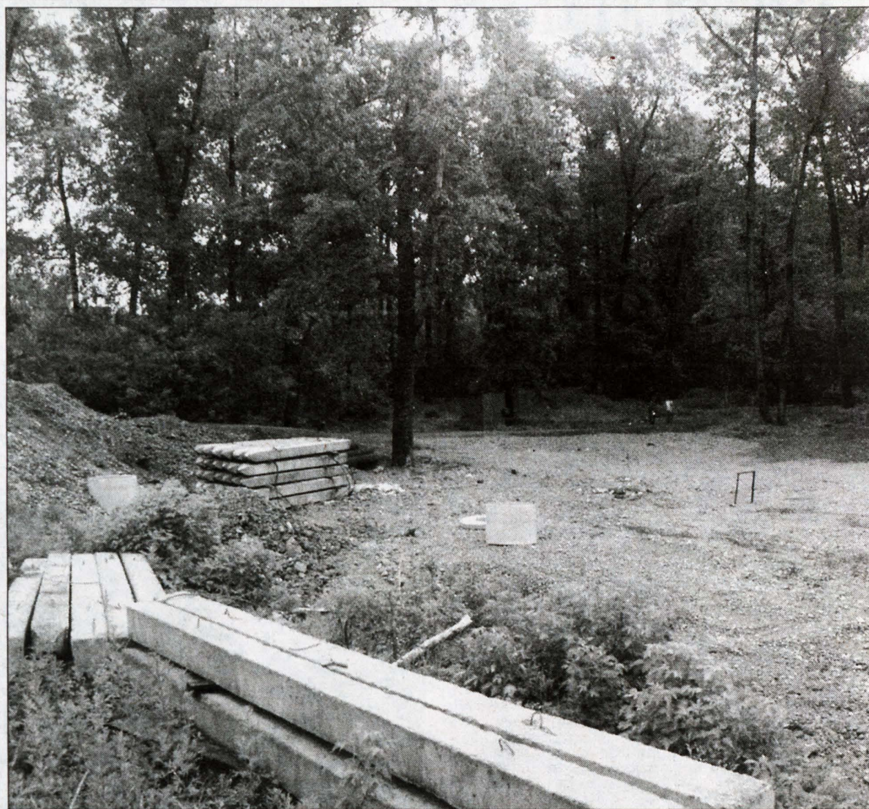
На стройплощадке будущей АЗС.
