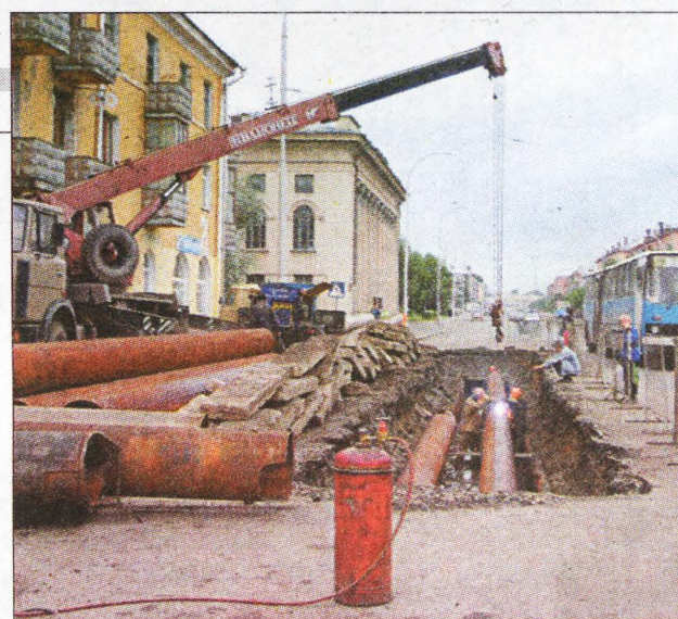
Замена теплотрассы по ул. Дзержинского в Кемерово.
