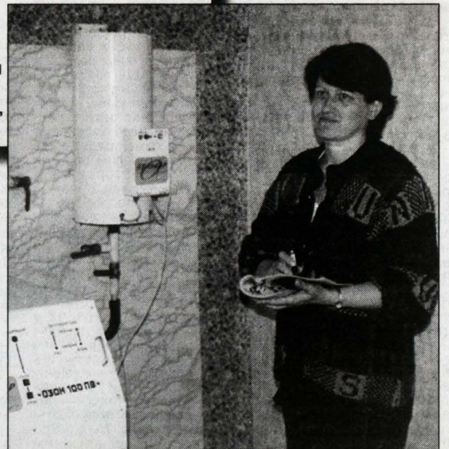
Шахтовая озонаторная для очистки шахтных вод — одна из образцовых на Ленинском руднике.
