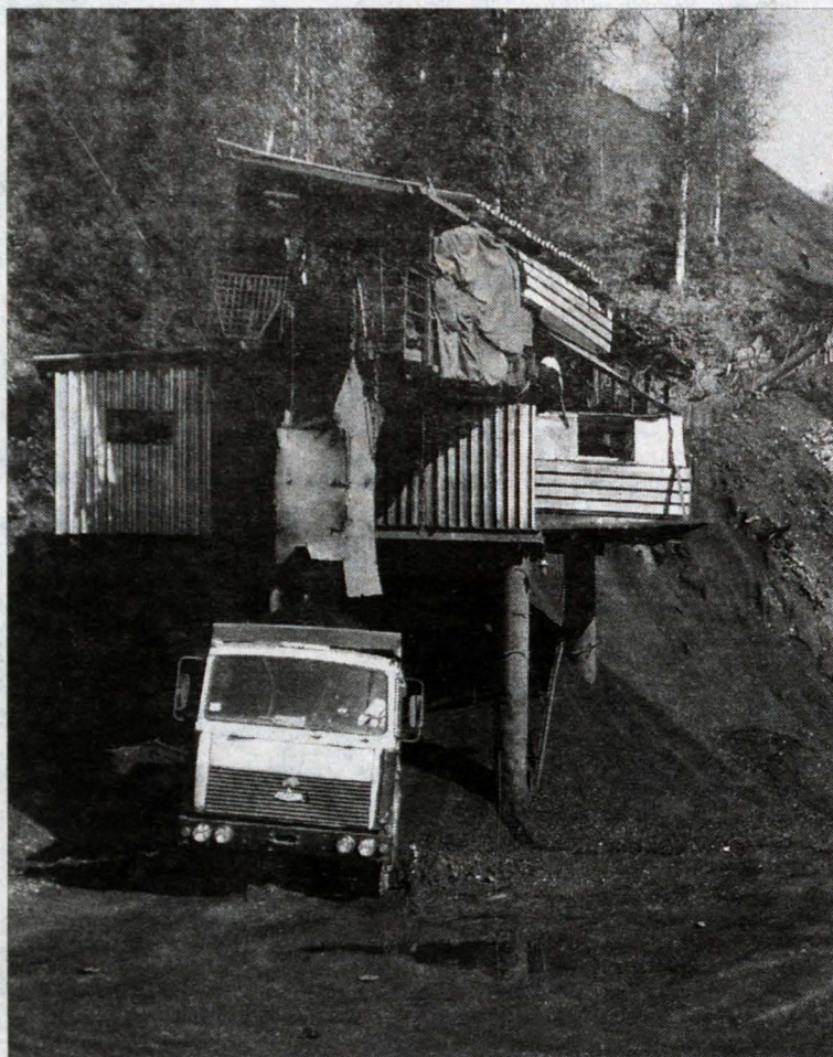
Шахта МУК-96 не только строится, но и дает уголь.
