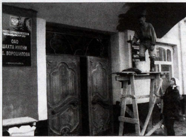
Ремонт административного здания.
