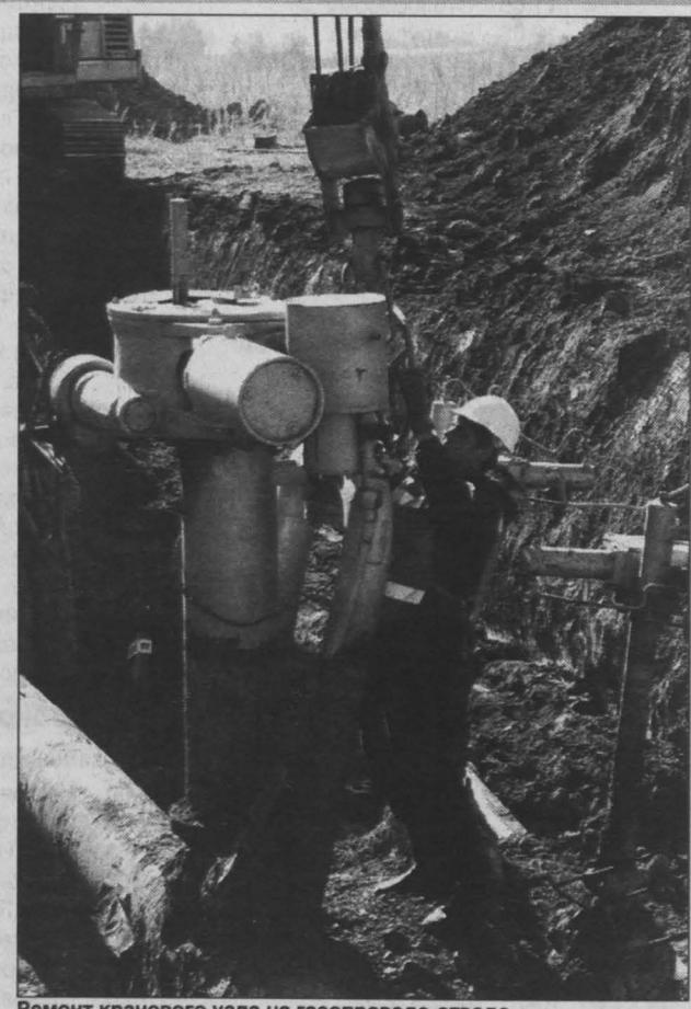
Ремонт кранового узла на газопроводе-отводе.
