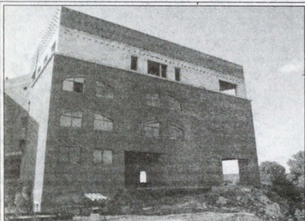
Строящийся корпус медицинского центра.
