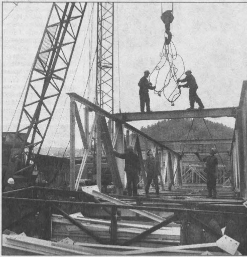
НА СНИМКАХ: легендарный Кузнецкий металлургический комбинат. Отсюда начиналась трудовая летопись коллектива «Сибметаллургомонтаж», бригада монтажников технологического оборудования, руководимая А. И. Лепетухиным из ОАО «Сибметаллургомонтаж», в эти дни ведет сборку металлоконструкций галереи обратной подачи угля на строительстве шахты «Томусинская 5-6» в г. Междуреченске; генеральный директор ОАО «Сибметаллургомонтаж» Юрий Константинович Потылицын.
