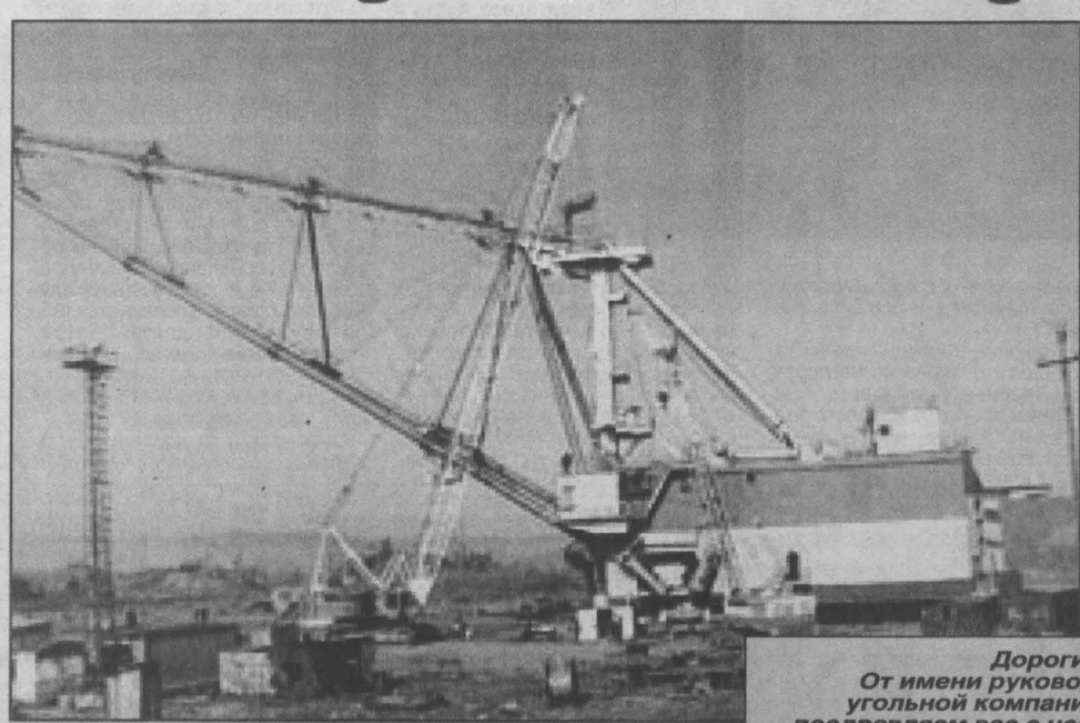
На разрезе «Томусинский» завершается монтаж нового оборудования.
