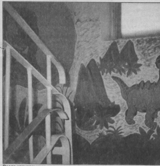
После капитального ремонта в одном из подъездов.
